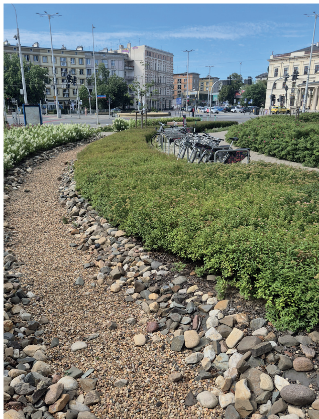
Przykład powierzchni retencyjnej w formie suchego strumienia.
