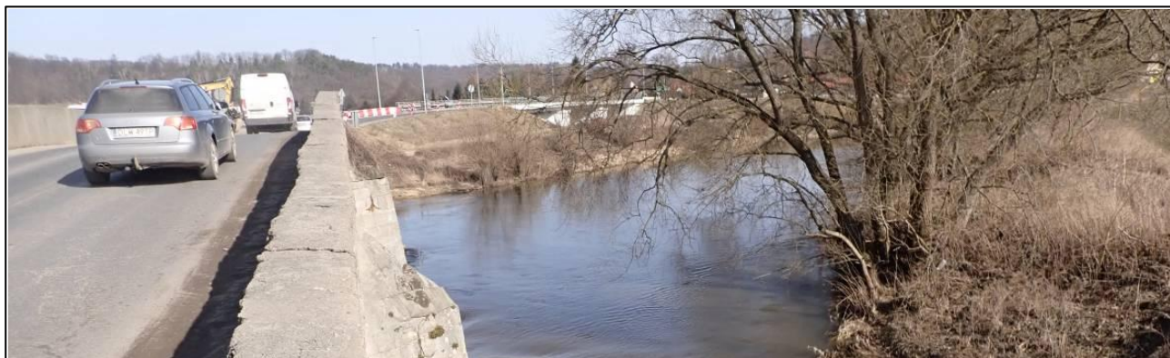
Foto 13. Most drogowy nad Bobrem w Lwówku Śl. W tle most nad kanałem ulgi.
