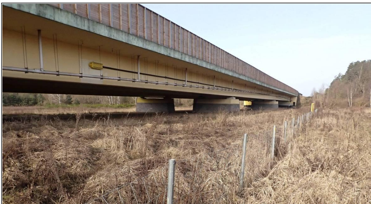
Foto 5. Autostrada A18, most nad Bobrem.
