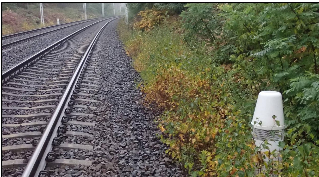
Foto 9. Magistrala kolejowa koło Zielonki z urządzeniem odpłaszczacza akustycznego.
