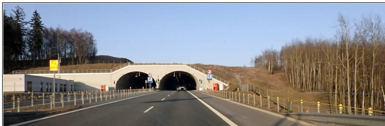
Foto 8. Droga ekspresowa S3, tunel.
