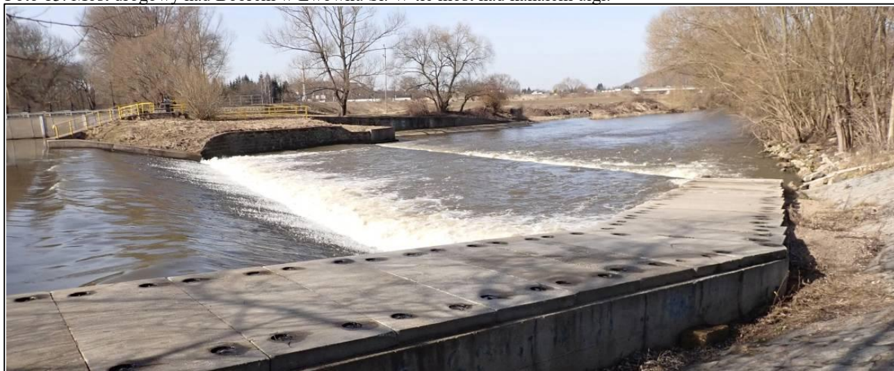
Foto 14. Dolina Bobru koło Lwówka Śląskiego, jaz rozdzielający nurt do MEW.
