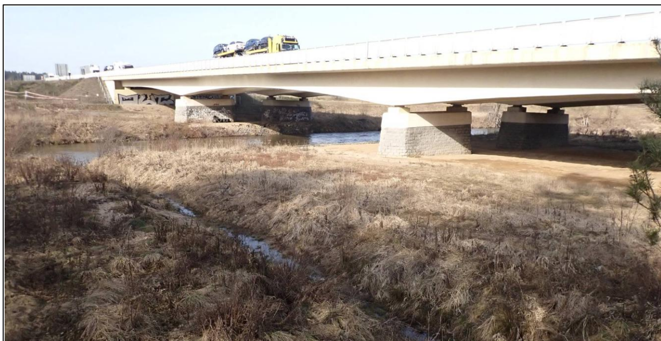
Foto 3. Autostrada A4, most nad Bobrem.
