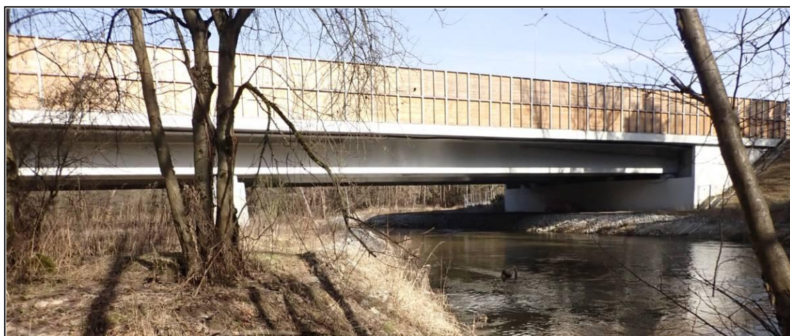
Foto 6. Autostrada A18, most nad Kwisą.
