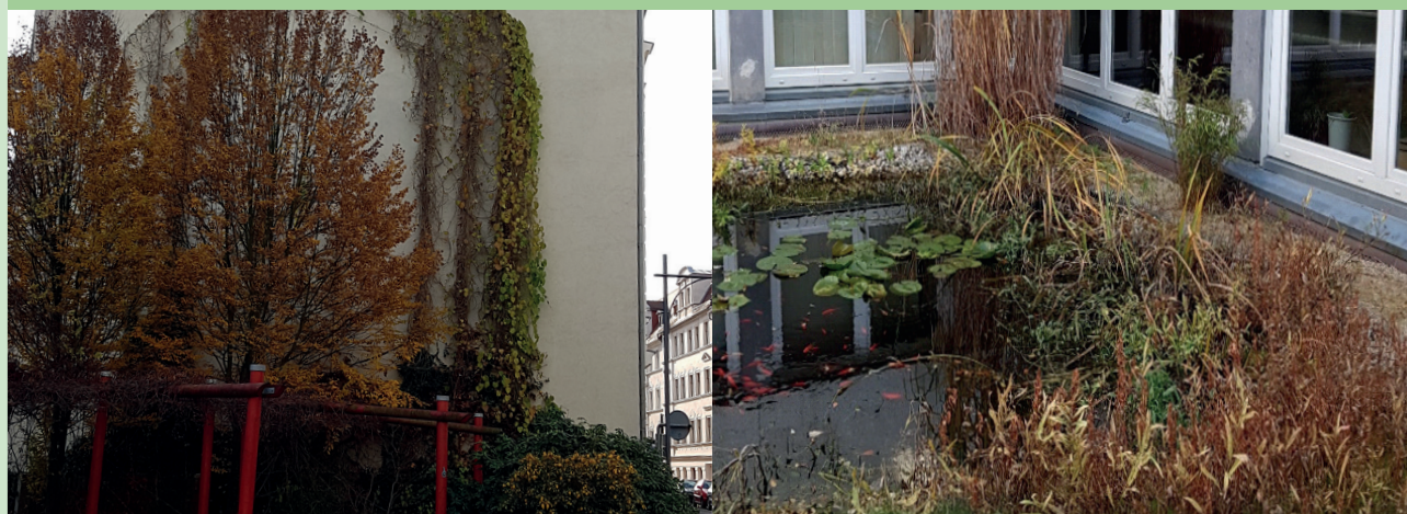
Zielona ściana prowadzona na podciągach
