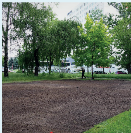
Przygotowanie terenu pod łąkę kwietną
