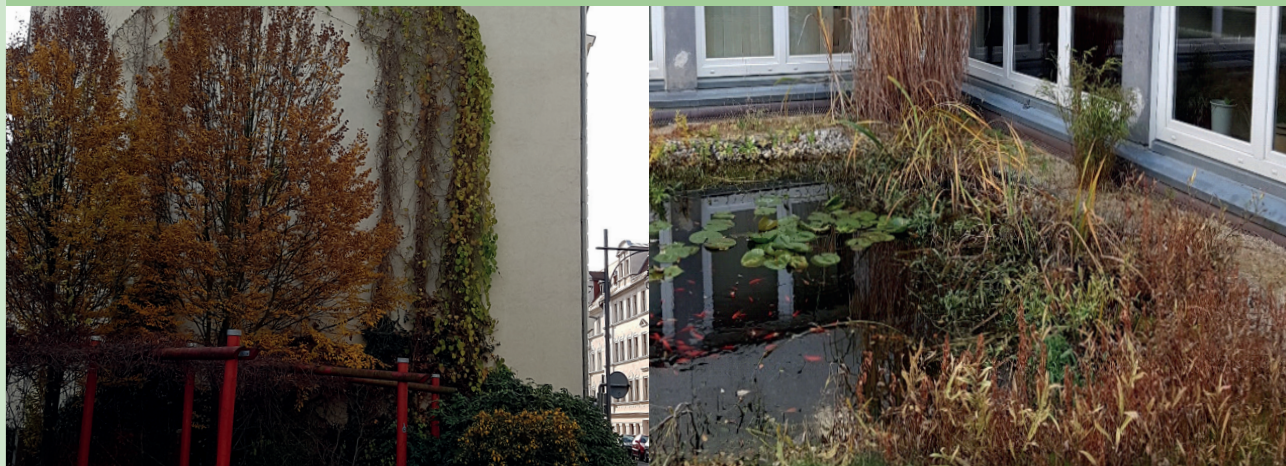
Zielona ściana prowadzona na podciągach
