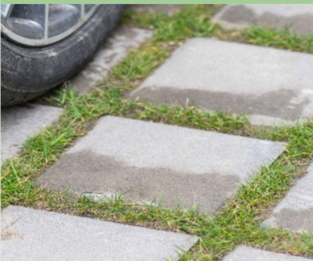
Półprzepuszczalne parkingi i ścieżki w parkach osiedlowych
