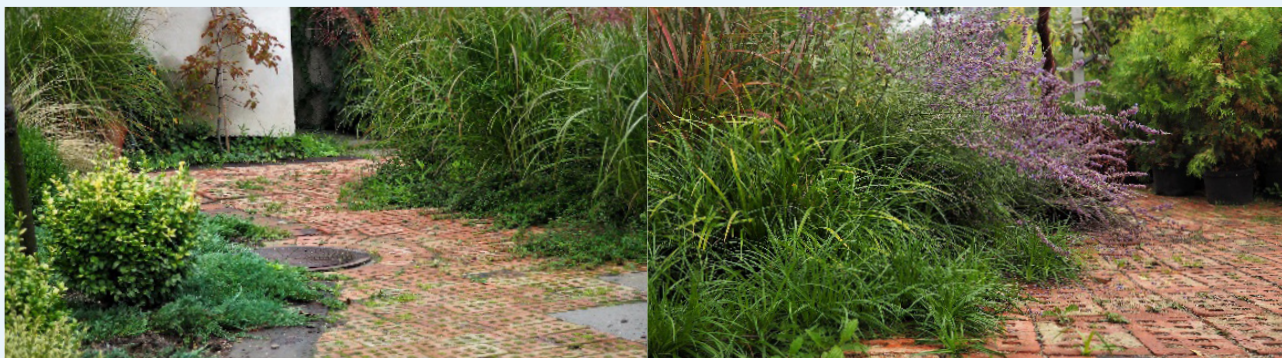
Nawierzchnie z cegły rozbiórkowej
