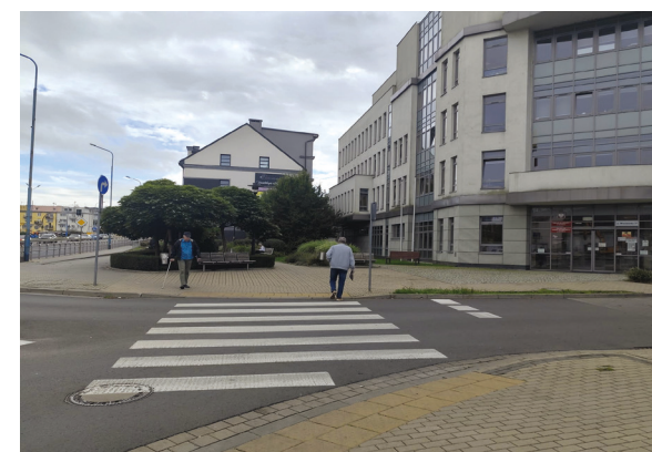
Przejście dla pieszych z obniżonym krawężnikiem i bezprogowym dojściem – rozwiązanie poprawiające dostępność przestrzeni publicznej dla seniorów i osób z ograniczoną mobilnością.
