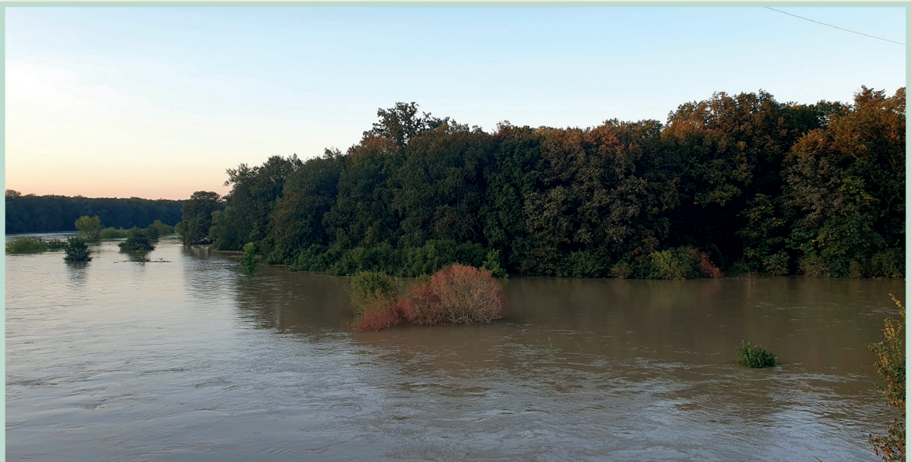
Wysoka woda na Odrze – sytuacja wymagająca sprawnego systemu reagowania.
