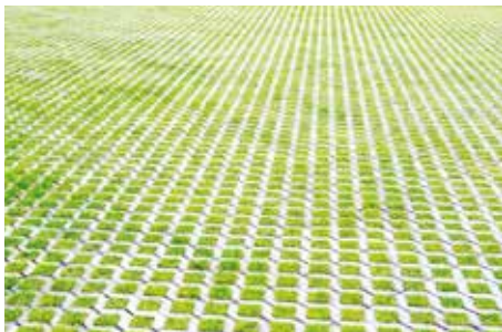
Płyty ażurowe przepuszczają wodę
