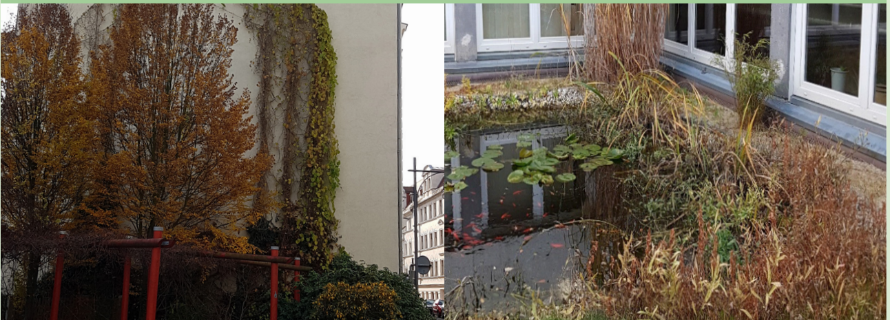
Zielona ściana prowadzona na podciągach
