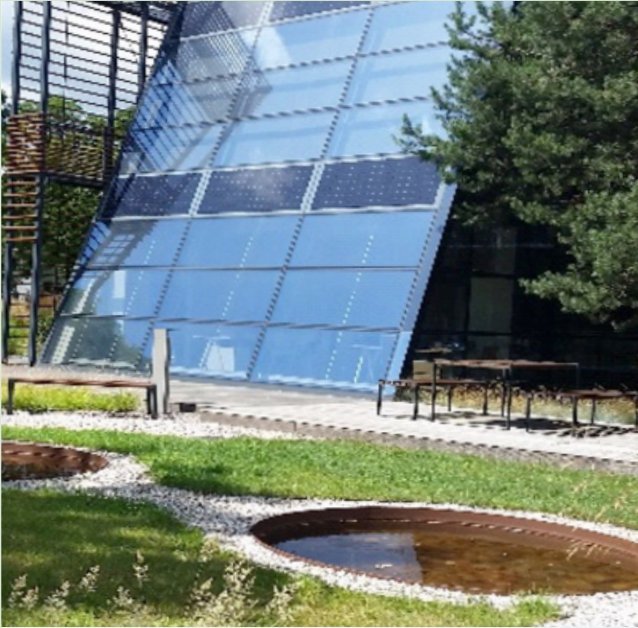
Gromadzenie wód deszczowych z dachu w oczkach wodnych
