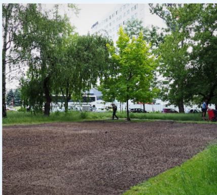
Przygotowanie terenu pod łąkę kwietną
