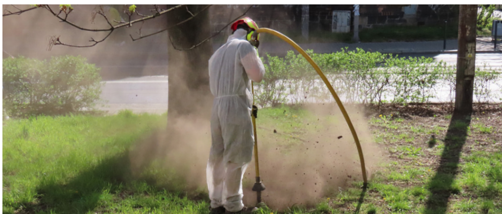
Wykonywanie prac ziemnych w Strefie Ochrony Drzewa (SOD) przy użyciu sprężonego powietrza (fot. P. Reda).
