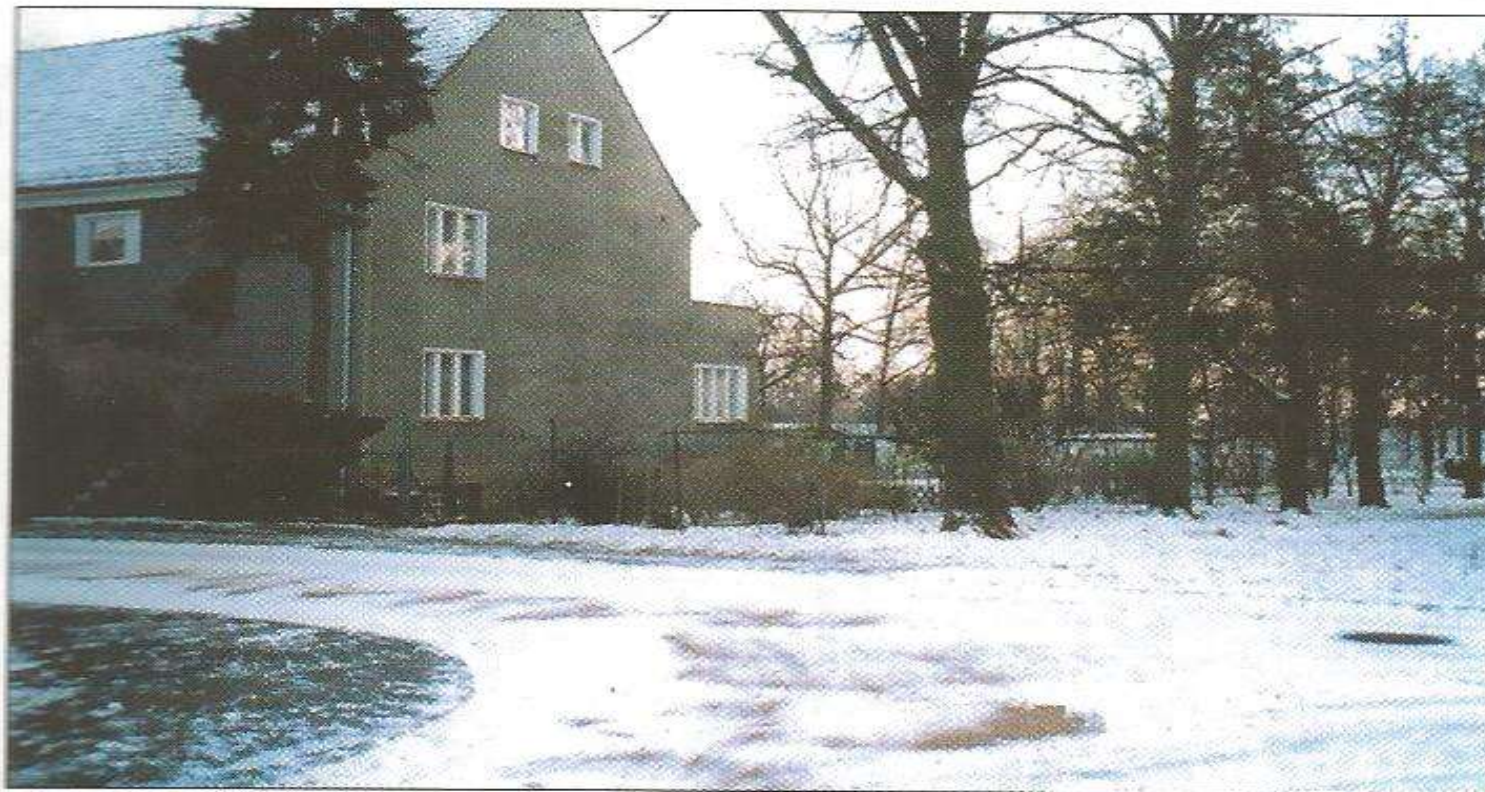
Fot. 3. Wrocław – osiedle Biskupin. Między I a II wojną światową zaprojektowane i wybudowane budynki mieszkalne sytuowano w odpowiedniej odległości od wału przeciwpowodziowego, z wyniesieniem parteru ponad jego koronę
