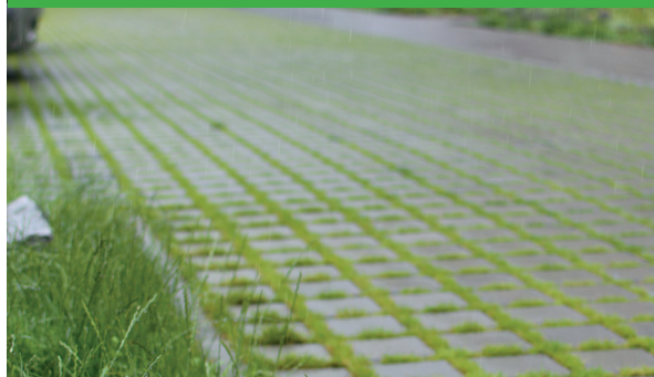
Przepuszczalne powierzchnie na parkingach i drogach osiedlowych retencjonują wodę Durchlässige Oberflächen auf Parkplätzen und Straßen speichern Wasser
