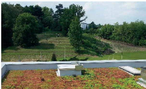
Zielony dach, zielona ściana i edukacyjna ściana z różnymi gatunkami rozchodników zasilana deszczówką Ein grünes Dach, eine grüne Wand und eine für Bildungszwecke geeignete Wand mit verschiedenen Gattungen von Sedum, die vom Regenwasser gespeist werden
