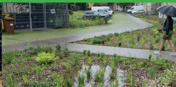
Gromadzenie deszczówki w ogrodzie deszczowym Speichern von Regenwasser im Regengärten
