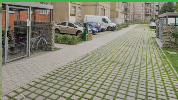
Przepuszczalne powierzchnie na parkingach i drogach osiedlowych retencjonują wodę Durchlässige Oberflächen auf Parkplätzen und Straßen speichern Wasser
